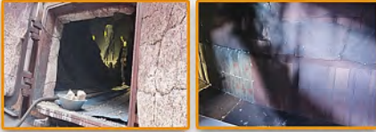
▲ نسوز کاری انولار ▲ نسوز کاری سیگمنت های کوره دوار
