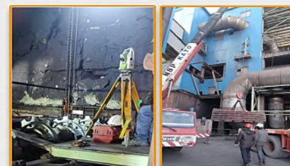
▲ دمونتاز زنجیر قدیمی گریت ماشین ▲ نقشه برداری جهت تنظیم گریت ماشین
