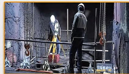
▲ نقشه برداری جهت تنظیم گریت ماشین
